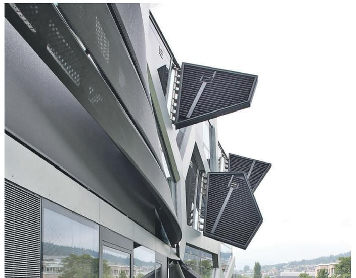
Die 4 Heizflügel sind an der Westseite des Gebäudes angebracht. Mit Sonnenaufgang öffnen sich die Flügel. Um die maximale Solarstrahlung absorbieren zu können, folgen die Flügel dem Sonnenlauf.
