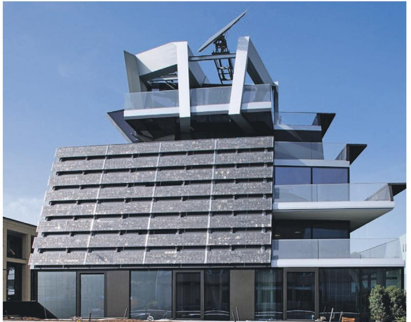
Die gesamte geneigte und verbreiterte Südseite des Gebäudes wird zur Stromerzeugung genutzt. Die Farbe der anderen Fassadenteile korrespondiert mit den Farbnuancen der bronzefarbenen Fotovoltaikzellen.
