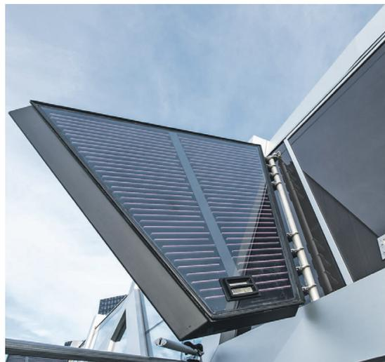
Die Kühlflügel sind an der Ostseite des Gebäudes angebracht, sie werden vor allem nachts geöffnet. Aufgrund der Achslage der Flügel kann eine Neigung im geöffneten Zustand erzielt werden. Dies erleichtert die Wärmeabstrahlung in den Himmel – idealerweise in sternenklaren Nächten in das Weltall.
