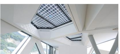
Das gesamte Dach und die Südseite des Gebäudes werden zur Gewinnung von Solarenergie genutzt
