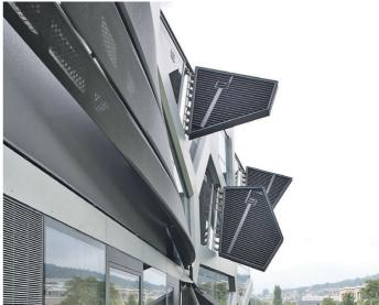
Die 4 Heizflügel sind an der Westseite des Gebäudes angebracht. Mit Sonnenaufgang öffnen sich die Flügel. Um die maximale Solarstrahlung absorbieren zu können, folgen die Flügel dem Sonnenlauf.
