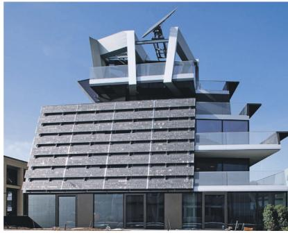
Die gesamte geneigte und verbreiterte Südseite des Gebäudes wird zur Stromerzeugung genutzt. Die Farbe der anderen Fassadenteile korrespondiert mit den Farbnuancen der bronzefarbenen Fotovoltaikzellen.
