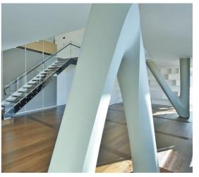
Das Tragwerk besteht aus A- und V-förmigen Stützen aus Fertigteilelementen.
