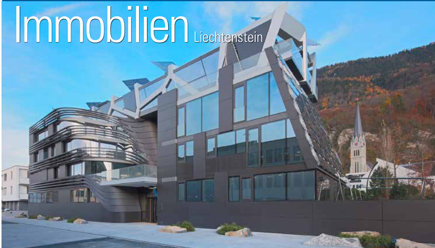
Marxer Active Energy Building, Südwestfassade
