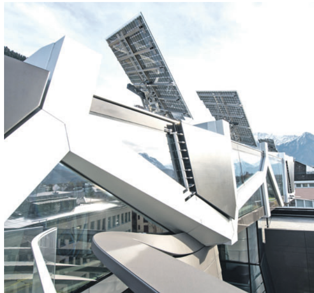
Ausgeklügelte Technik: Die Fotovoltaik-Elemente auf dem Dach (links) richten sich nach der Sonne aus, damit kann eine circa 40 Prozent höhere Effizienz erreicht werden. Die ausklappbaren PCM-Klima-Flügel (rechts) wurden eigens für das Gebäude entwickelt und patentiert. Damit lässt sich auf kleinem Raum sehr viel Wärme oder Kälte speichern.
