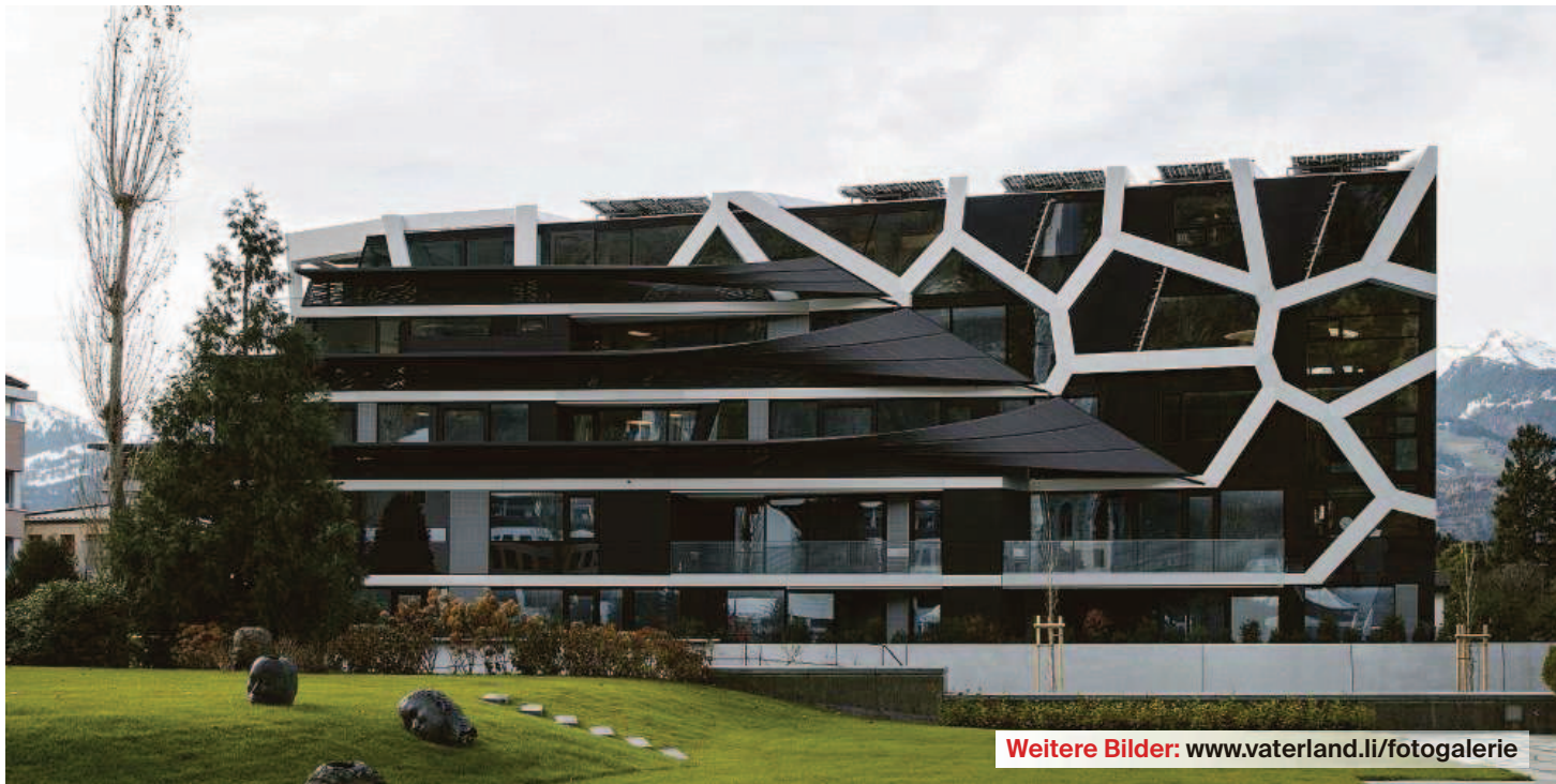
Das Active Energy Building besticht durch seine aussergewöhnliche Architektur und Nachhaltigkeit.
