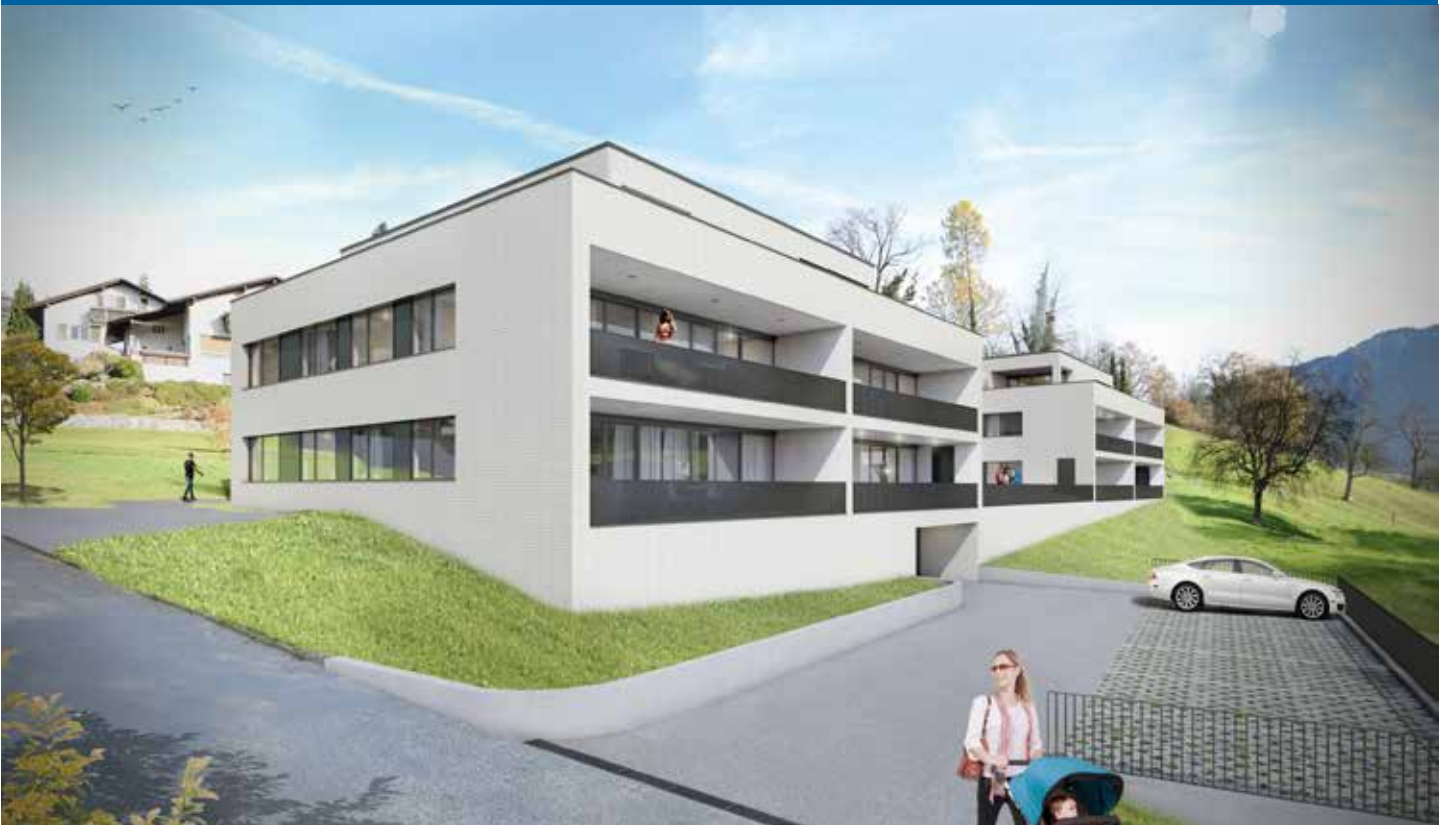
Kaufangebot: Neubau Eigentumswohnungen an der Tonagass in Eschen (Neubau 2016)
